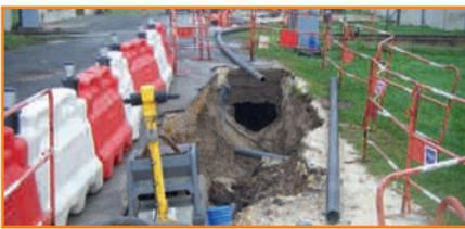
La réalisation du réseau pluvial a été suivie par les travaux de renouvellement des conduites d'eau potable et changement des branchements en plomb.
