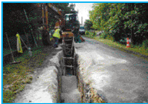
Assainissement, travaux rue des Moulinades, de la Source et de la Garenne.
