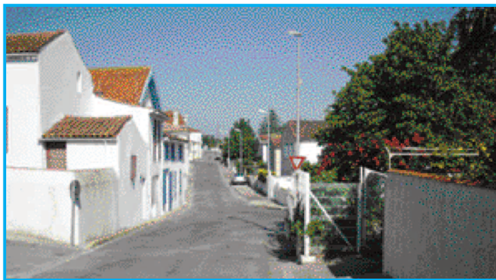
Avallon : fin des travaux d'enfouissement des réseaux télécom, EDF, Eclairage public
